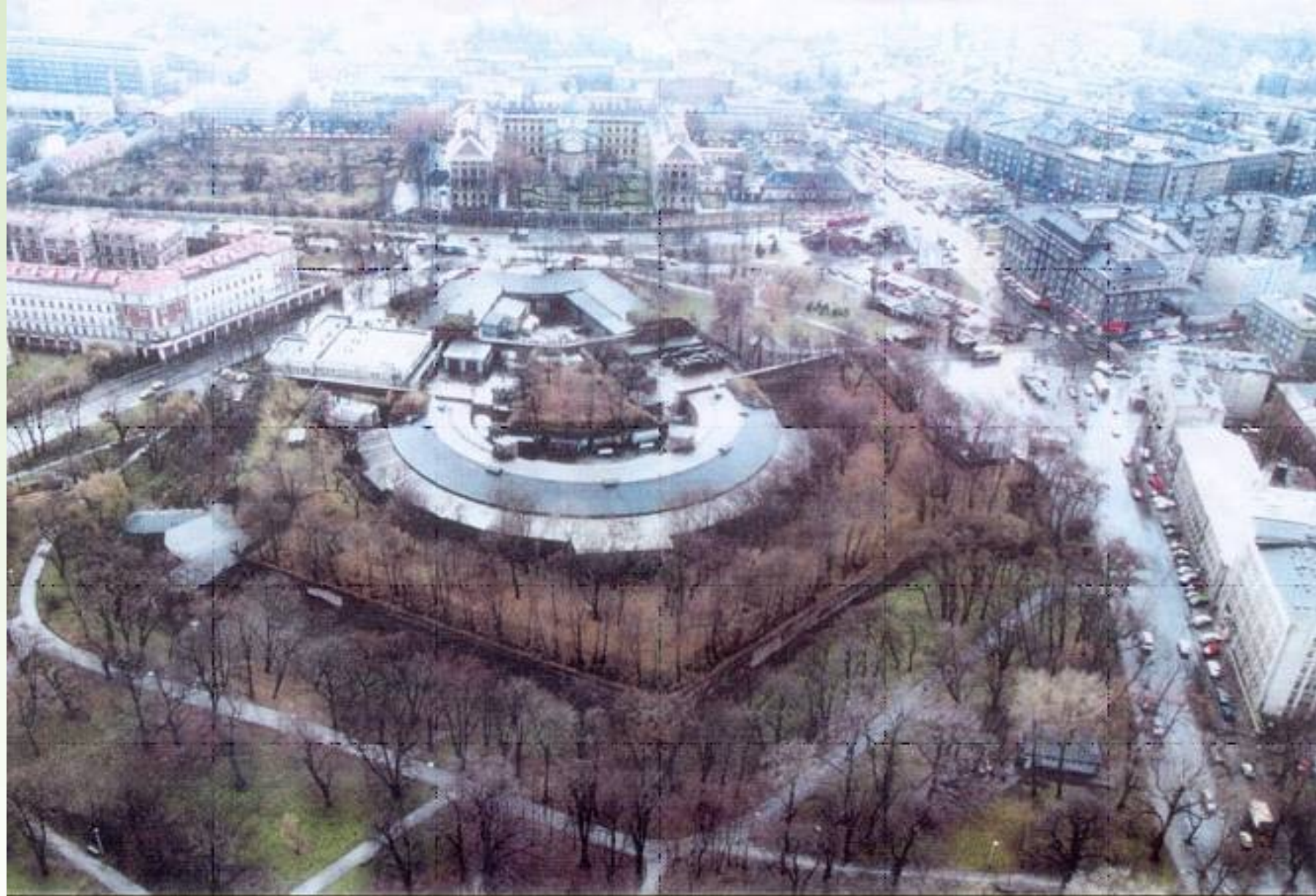
stan: przed rozpoczęciem rewaloryzacji - rok 1995 WIDOK Z LOTU PTAKA OD STRONY ZACHODNIEJ
