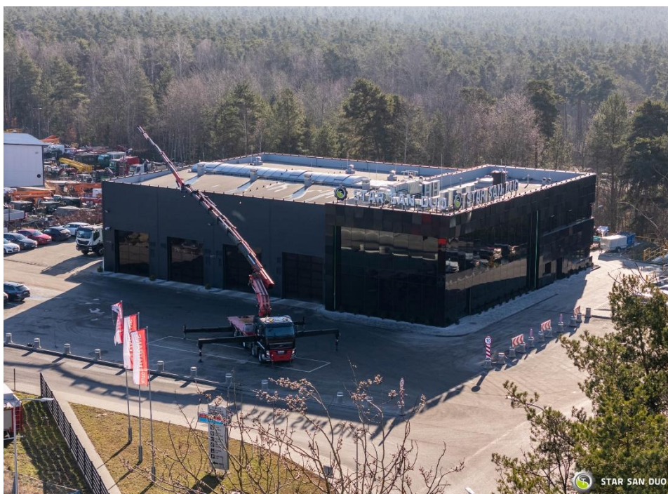
Fot. 4 Budynek usługowy serwisu samochodowego przy ul. Krańcowej w Starachowicach.
