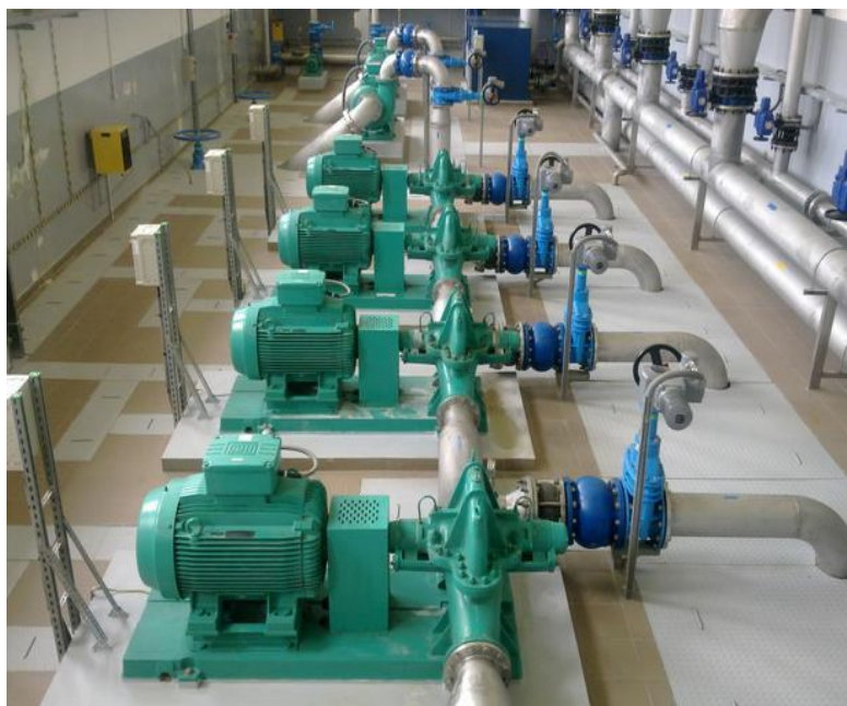
Hala pomp ujęcia wody w Trębowcu
