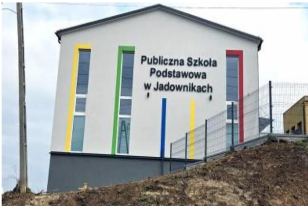
Fot. 1 sala gimnastyczna wraz z zespołem sanitarnym w Jadownikach gm. Pawłów
