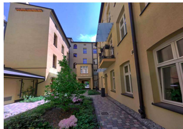
Narutowicza 12 – przed i po remoncie
