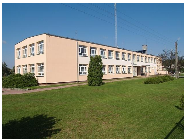
Rysunki 22-26. budynki po termomodernizacji.
