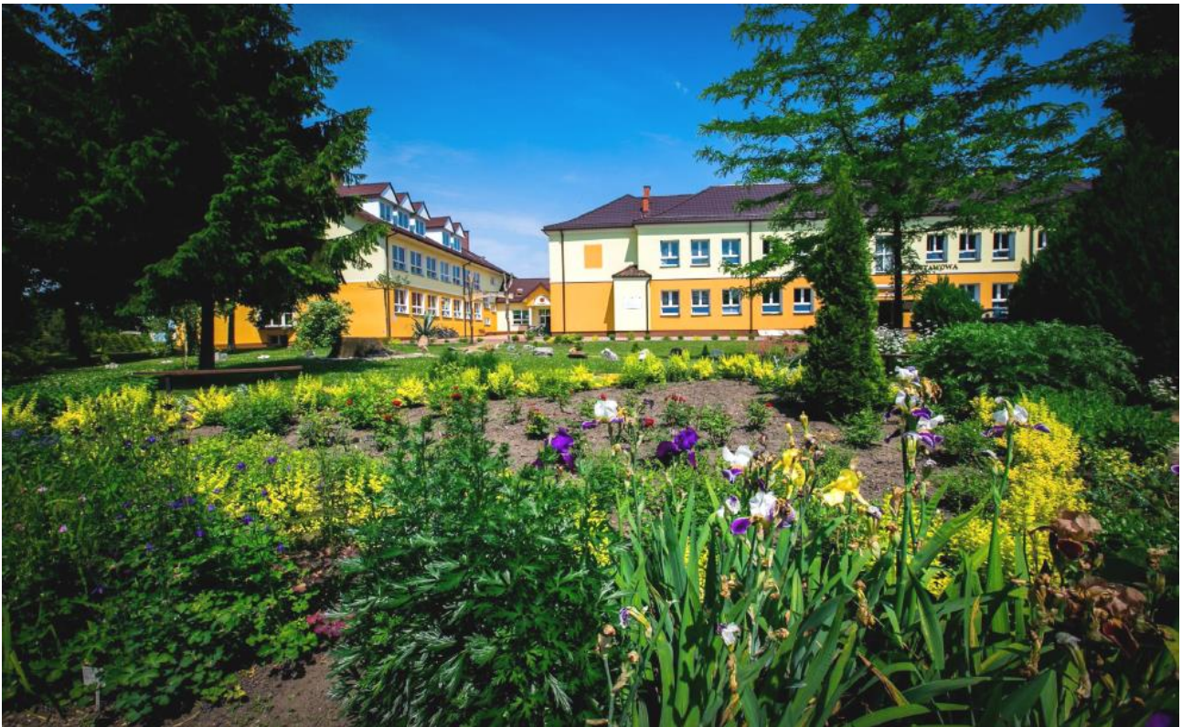
Rysunek 19. Budynek Zespołu Szkół w Mirczu po pracach termomodernizacyjnych i remontowych
