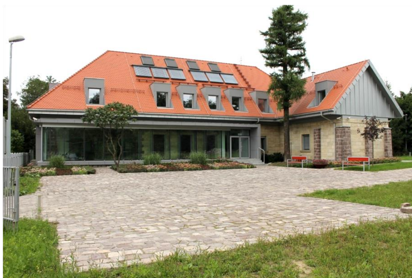
Rysunek 21. Budynek Laboratorium Edukacyjno–Badawczego Odnawialnych Źródeł i Poszanowania Energii WGGIOŚ AGH w Miękinii (stan po modernizacji)
