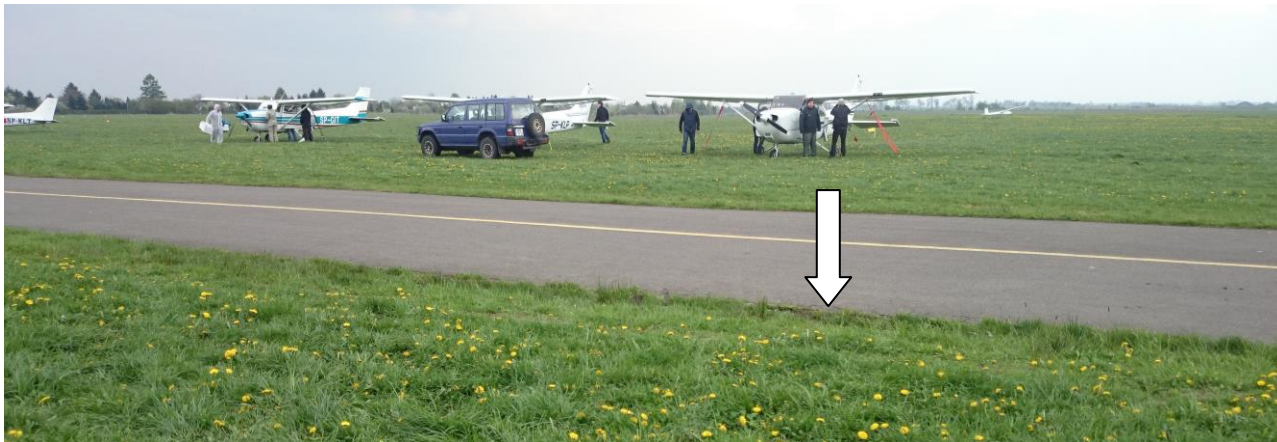
Rys.3. Próg na przejściu nawierzchni trawiastej i asfaltowej drogi kołowania
