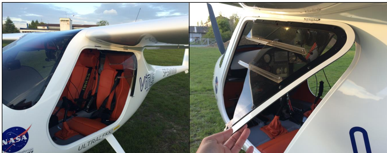
Rys. 1 i 2. Stan lewych drzwi po wypadku oraz część ramy lewych drzwi i oszklenia z zawiasami.
