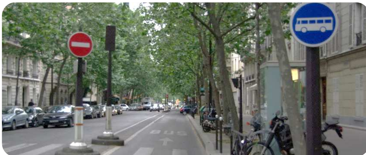
Kontrapas autobusowy z widocznym wąskim pasem dzielącym i separującym przeciwny kierunek ruchu.
