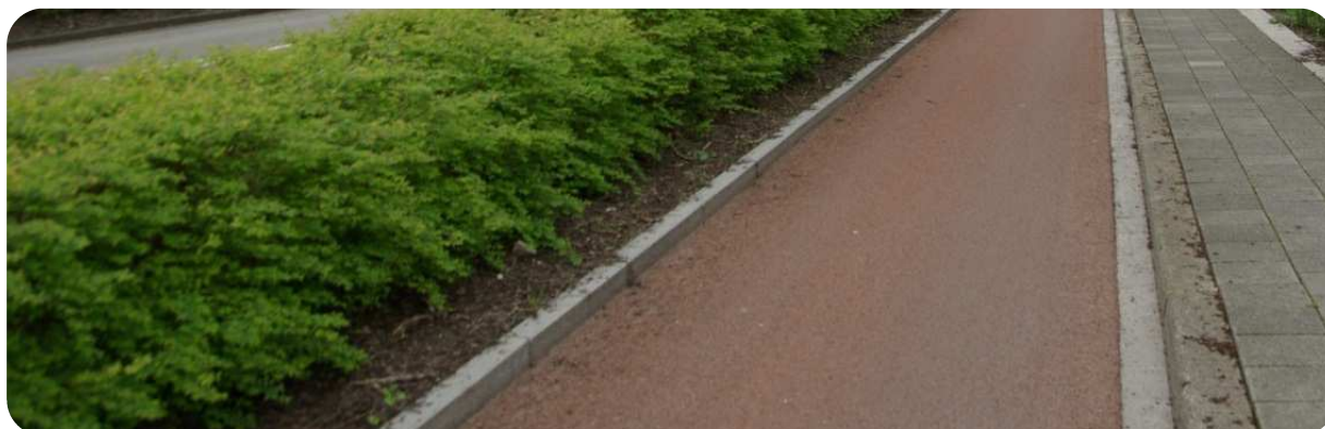
Przykład nawierzchni bitumicznej drogi rowerowej z czerwonym kolorem nawierzchni.
