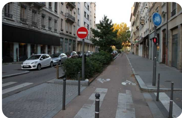
Przykład wykorzystywania zieleni do urządzania przekroju ulicy. Widoczne optyczne zwężenie przestrzeni przeznaczonej do ruchu pojazdów z „ukryciem” parkowania w cieniu drzew.
