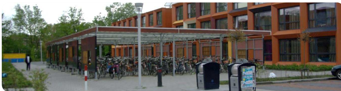
Przykład zadaszonego parkingu rowerowego usytuowanego blisko wejścia do budynku.
