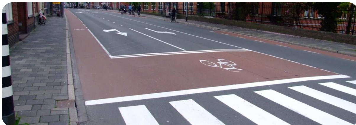
Pas dla rowerów w połączeniu ze służą rowerową na wlocie skrzyżowania z sygnalizacją świetlną.
