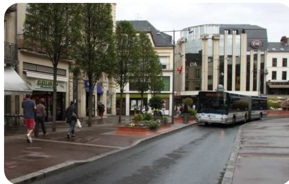
Wydzielona, jednokierunkowa jezdnia autobusowa, w centralnej, handlowej części miasta, bez ruchu samochodowego.
