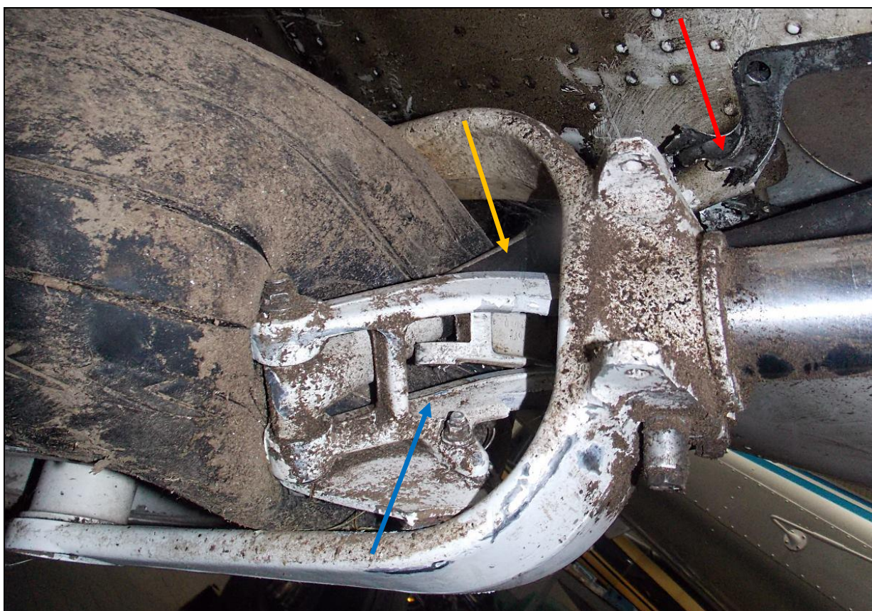
42 - Zbliżenie na głaz amortyzatora i dolny węzeł podwozia (zamocowanie widełca koła) – przód, lewa strona. Widoczne zniszczone elementy kinematyki wgniecione w ogumienie koła. Widoczne uszkodzenia i deformacje struktury kadłuba [czerwona strzałka]. Pomarańczową strzałką wskazany zgięty zastrzał podwozia, niebieską – ramie zastrzału, odłamane od swej obejmy na goleni i wciśnięte między widelec a ogumienie koła.
