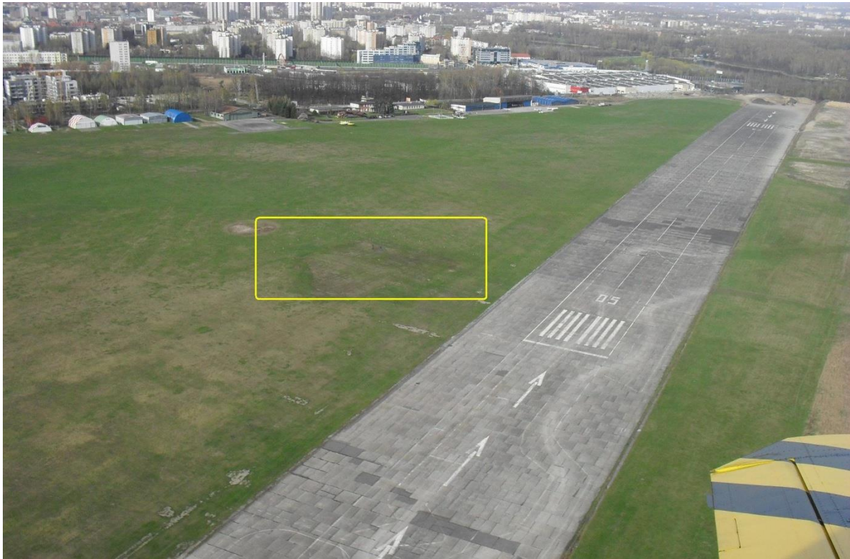
Ogólny widok lotniska. Żółtym prostokątem oznaczono miejsce zdarzenia.
