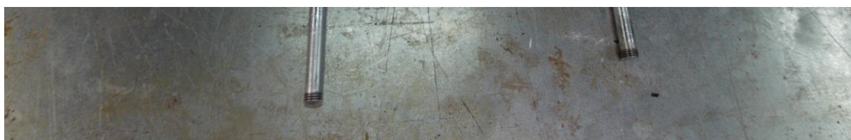
Rys. 12. Urwane w części gwintowanej końcówki szpilek [foto PKBWL]
